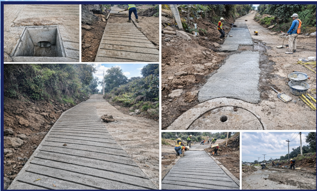
Construcción de drenaje sanitario en Barrio Canales, Santa Cruz Ayotuxo
