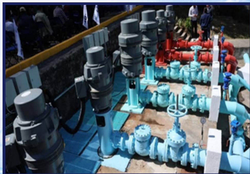
Rehabilitación de la estación de rebompeo de agua potable Lomas Country Club
