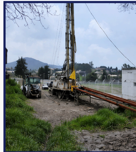
Perforación de pozo profundo a 350 m, El plan
