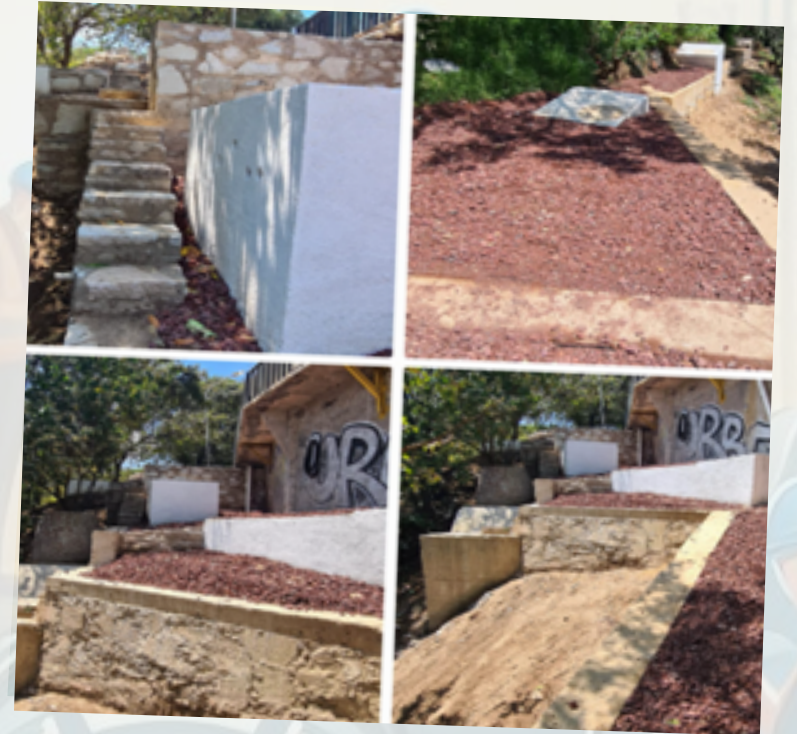
CONSTRUCCIÓN DE COLECTOR Y DESCARGA GENERAL, TIERRA Y LIBERTAD
